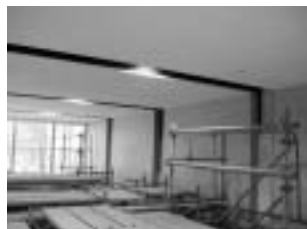
1階ホール天井部分
