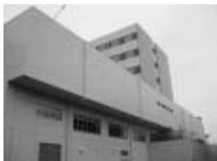
足場の取れた外観北面
