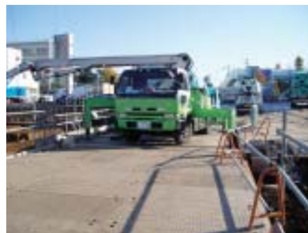
基礎躯体工事
